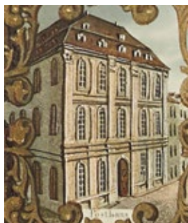
Abbildung 10. Das Posthaus auf dem gedruckten Mähly-Plan von 1847 (Legende Nr. 12 und Vignette 34, vgl. Abb. 29). Mähly-Plan, 1847 (1:1).
