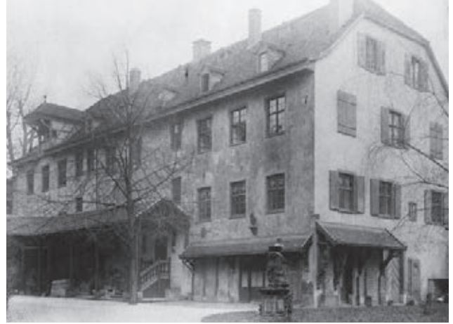
Abb. 4 Blick in den Hof zwischen Barfüsserkirche und Verwaltungsgebäude, undatiert, Archiv Kantonale Denkmalpflege Basel-Stadt.
